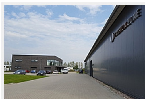
Der ADCADA Park in Rostock Bentwisch - Lagerhalle und Büroeinheit
